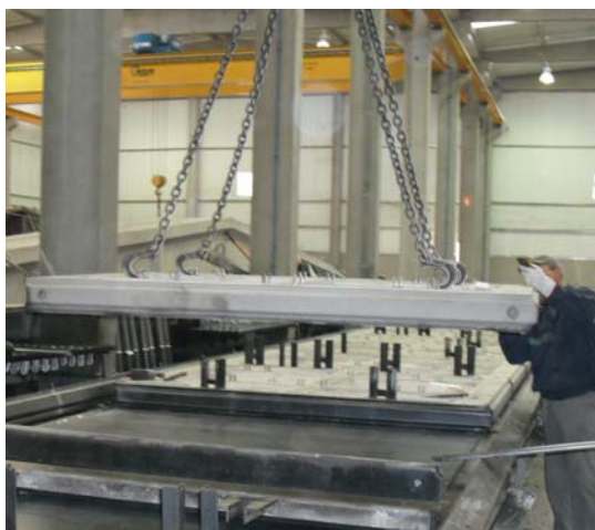
Foto 1 – Desmoldagem e elevação do painel da mesa de fabrico
