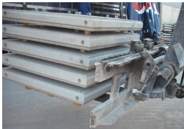
Foto 6 – Carga do camião com painéis
