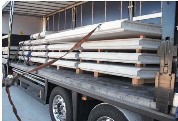
Foto 7 – Ajuste das cintas para evitar deslizamento da carga
