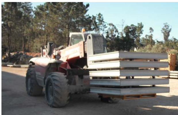
Foto 4 – Transporte de painéis com empilhador para armazenamento no exterior
